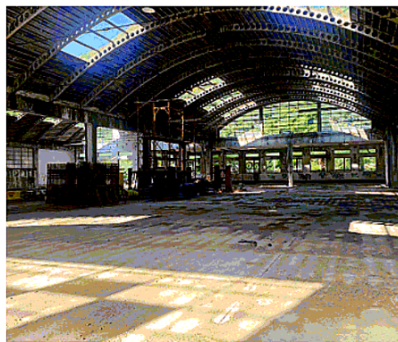
L'interno della struttura
